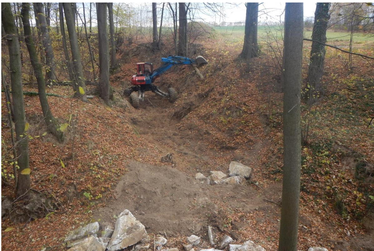
Rokle před soutokem s hlavním korytem ve správě Povodí Odry. Pod (před) rypadlem je znatelné ozubení pro propojení valu se dnem rokly.
